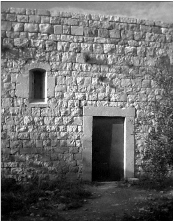
Una monofora strombata nella facciata Sud; l'ingresso è posticcio, conseguente alla parcellizzazione dell'immobile. (foto 2006).
