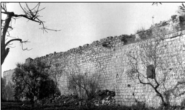
Prospetto Est del casale. Da "Andar per casali ...", cit.
